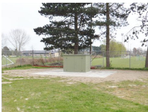
Boring B2 efter sløjfning
