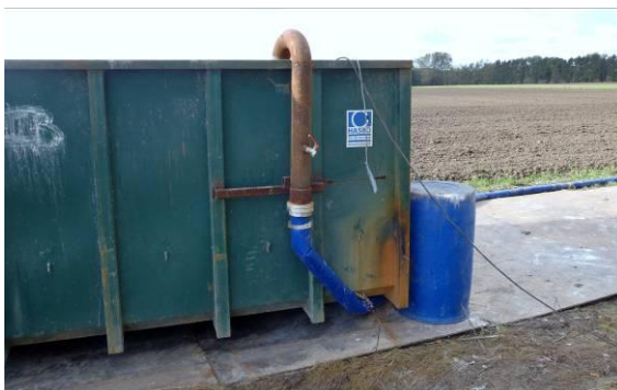
Kammer for bundfældning af slam i renpumpning.
