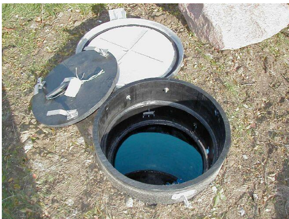
Aluminiums- og underdæksel til kammer åbnet.
