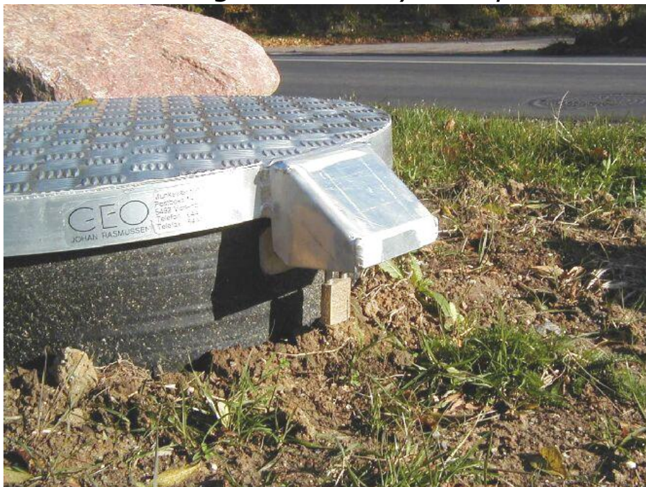
Aluminiumsdæksel med beskyttelsesdæksel over hængelås.
