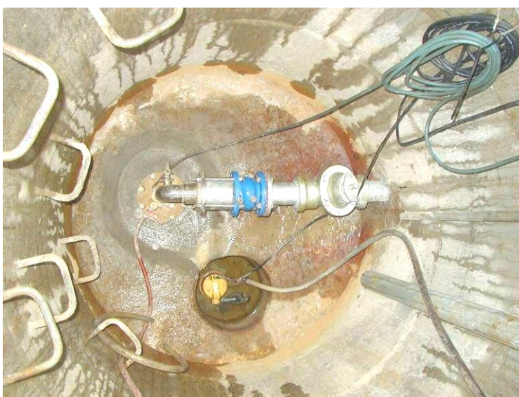
Overside af brøndkammer med fastboltet jernramme for dæksel, der er hævet 70 cm over terræn. NB: Nyt foto
