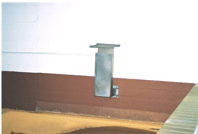
Udluftningshætte for udluftning af maskinrum
