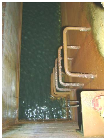
Henstandstank til bund-fældning af slam m.v. Tank-en er placeret under luft-indtagene i iltningstårn.
