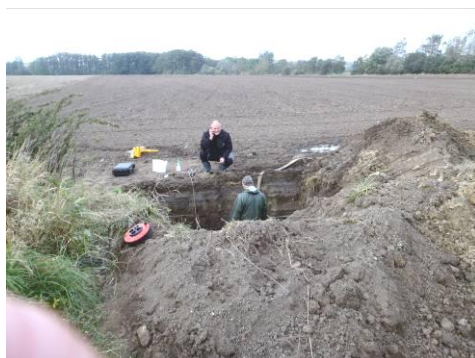
Forsyningsledning på mark frilagt.
