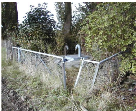
"Boring B6" før sløjfning.
