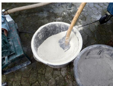
Bentonit til sløjfning af boring
