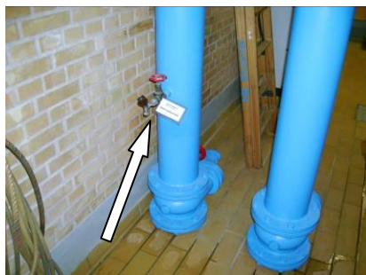
Prøvehane til udtagning af vandprøve til kontrol af drikkevandskvaliteten.
