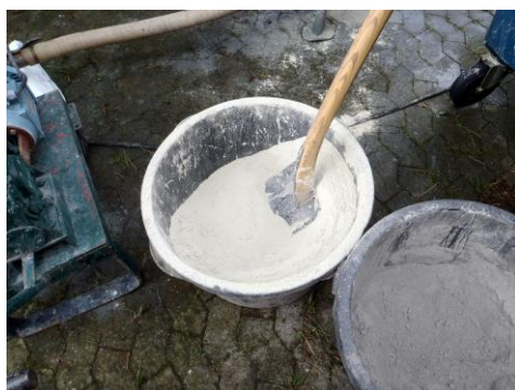
Bentonit til sløjfning af boring
