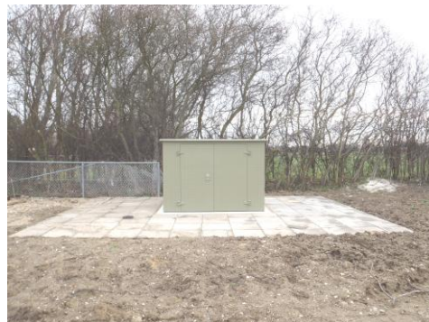
Boring B7 efter sløjfning
