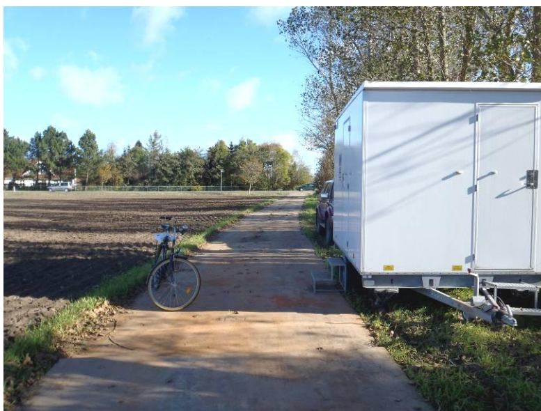
Kørevej fra Stevnsvej anlagt med stålkøreplader
