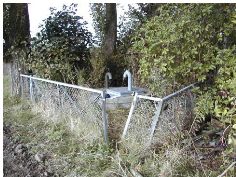
Boring B6 før sløjfning.
