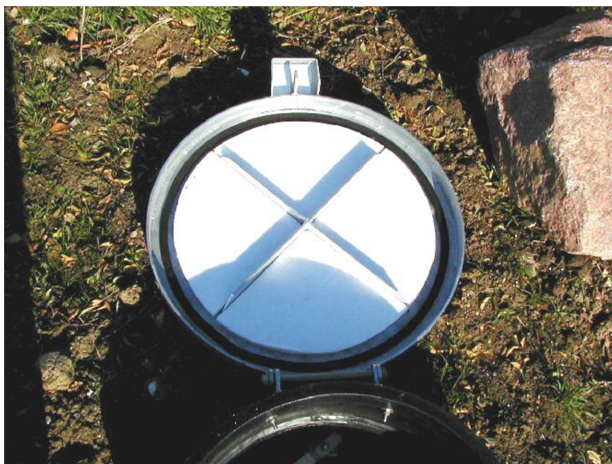
Isoleret underside af aluminiumsdæksel.
