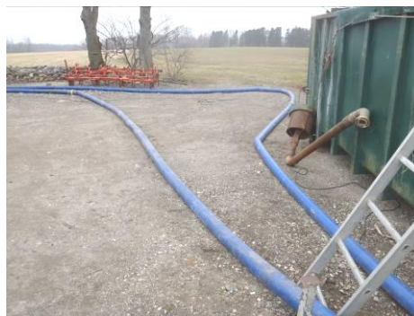
Slam i vand fra renpumpning bundfældes.
