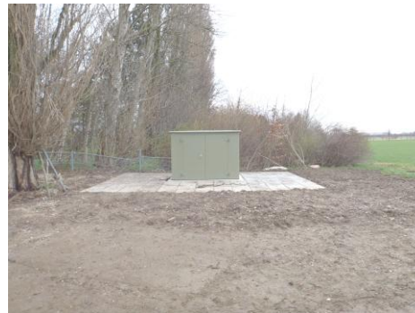
Boring B6 efter sløjfning
