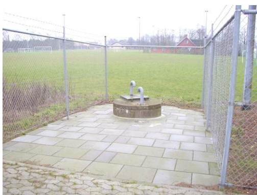
Boring B1 før sløjfning.
