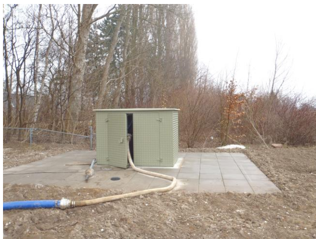
Renpumpning af erstatningsboring B6
