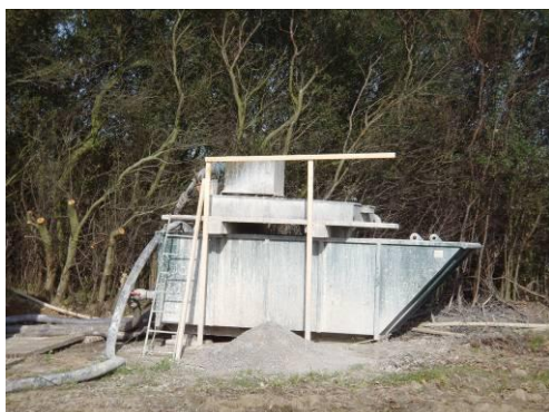
Bassin til opsamling af boreslam. Prøvepumpning efter filtersætning.
