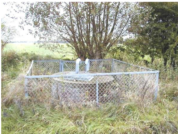
Overside af brøndkammer med fastboltet jernramme for dæksel, der er hævet 70 cm over terræn. NB: Nyt foto
