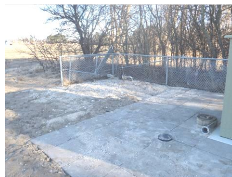
"Boring B7" efter sløjfning.
