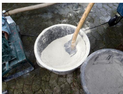
Bentonit til sløjfning af boring
