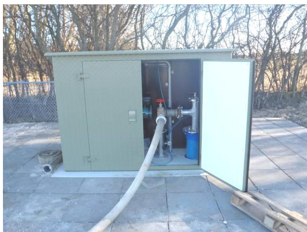
Renpumpning af erstatningsboring B7
