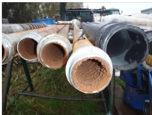
Foringsrør med okkerbelægning
