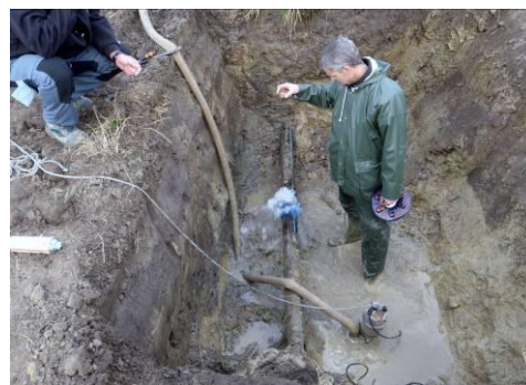
Sonden skydes ud af røret p.g.a. kraftigt vandtryk.
