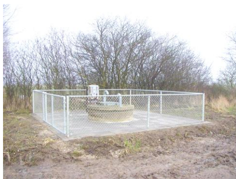
"Boring B7" før sløjfning.
