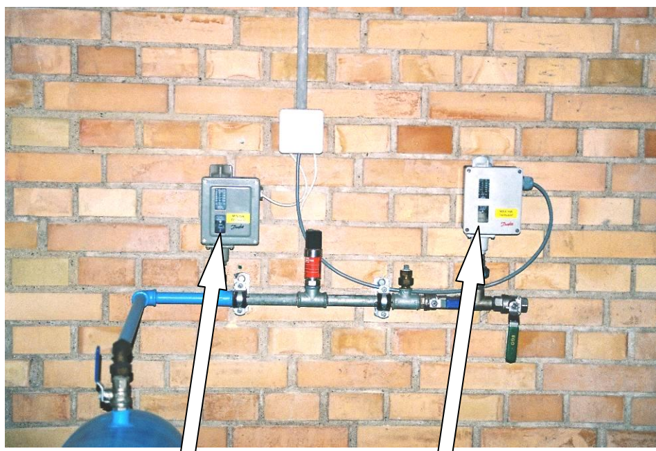
Pressostat for styring af min. trykket i afgang drikkevand.
