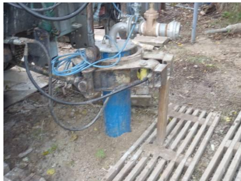
Bassin til opsamling af boreslam. Prøvepumpning efter filtersætning.
