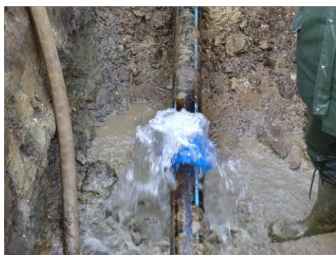
Sonden skydes ud af røret p.g.a. kraftigt vandtryk.
