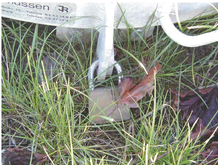
Aluminiumsdæksel med ubeskyttet hængelås.
