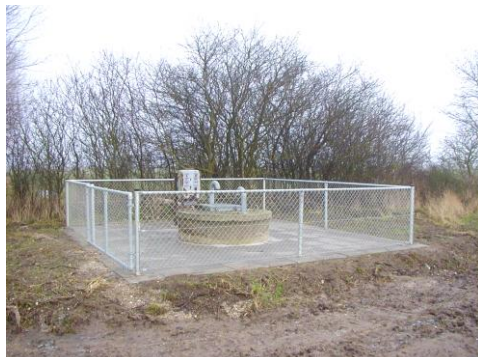
Boring B7 før sløjfning.
