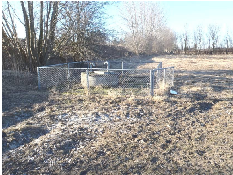
Anlæg set fra nordøst.
