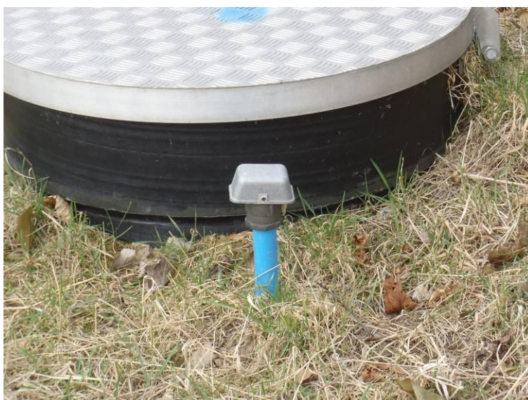
Transcientbeskyttelse ved lynnedslag.
