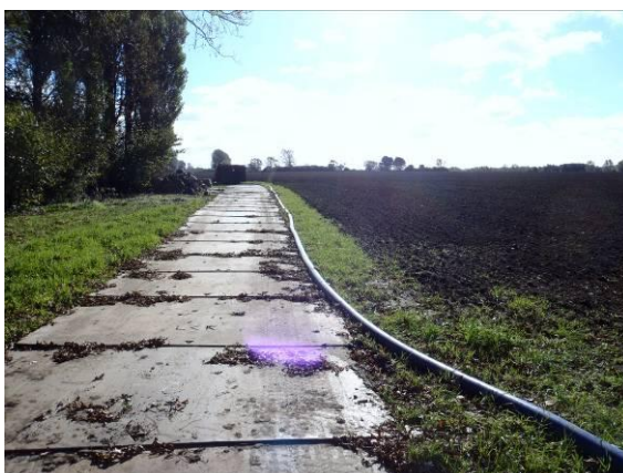
Ledning med skyllevand til udledning i vådområde ved Tryggevælde å. Se også under Boring B7
